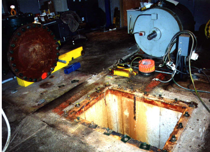
Figure 2: el Espacio para la nueva turbina de doble impulso está limitado. El flange de entrada de agua en el lado izquierdo, la apertura en el suelo para la descarga de la turbina y el eje del generador al fondo. La turbina y el reductor tenían que encajar entre ellos.
